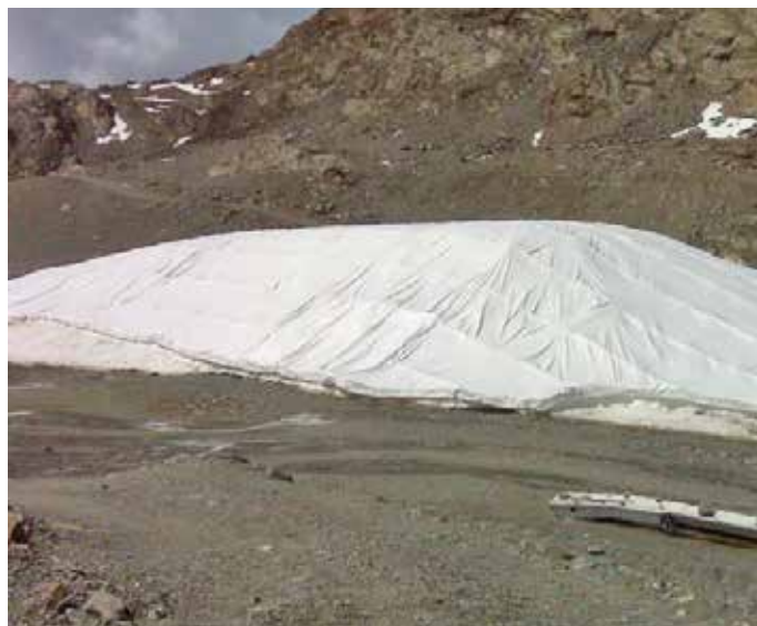
Fig. 6: Eksempler på geotekstilens effekt for å redusere snø-/isavsmelting: til venstre forskjellen mellom naturlig smeltet isbreeverflate og den bevarte snø-/isdybden under COVERICE-geotekstilen på Presena-breen (fra Senese med fl., 2013); til høyre den bevarte snømengden ved etablering av et snødeponi på Pitztaler-breen (Østerrike).
