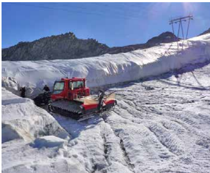
Fig. 6: Eksempler på geotekstilens effekt for å redusere snø-/isavsmelting: til venstre forskjellen mellom naturlig smeltet isbreeverflate og den bevarte snø-/isdybden under COVERICE-geotekstilen på Presena-breen (fra Senese med fl., 2013); til høyre den bevarte snømengden ved etablering av et snødeponi på Pitztaler-breen (Østerrike).
